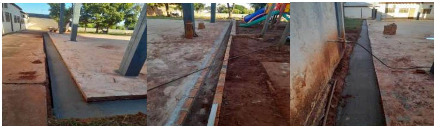
Construção da canaleta de drenagem.
