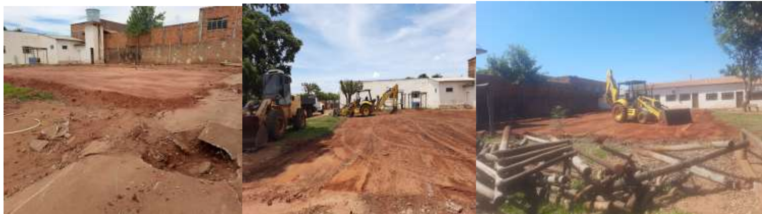
Início da montagem da estrutura metálica.
